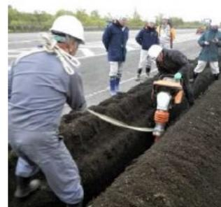
図 ランマによる締固め
