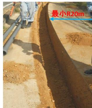
図 曲線施工状況
