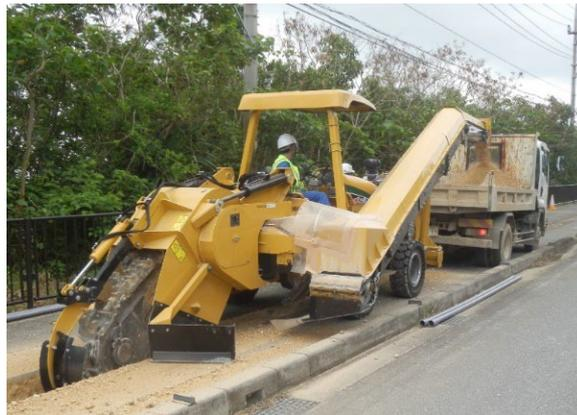
図 トレンチャーの作業形態（掘削＋土砂排出）
