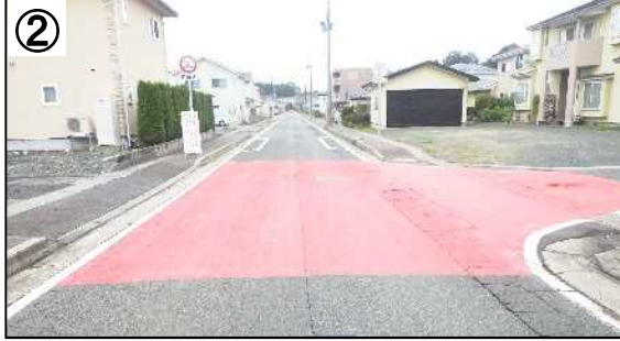
交差点カラー舗装
