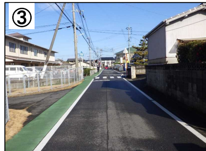
路肩のカラー舗装
