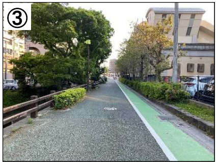
路肩カラー舗装
