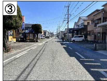
カラー舗装、中央線抹消
