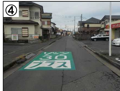
ゾーン30プラス路面表示
