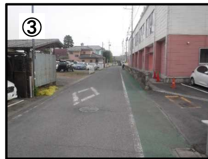
路肩カラー舗装
