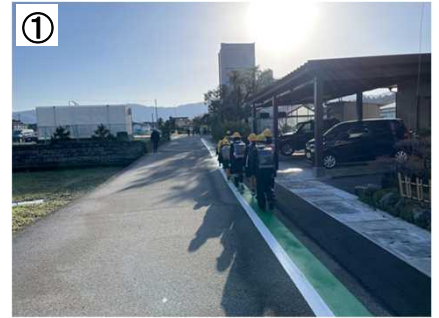
路側帯拡幅・カラー塗装
