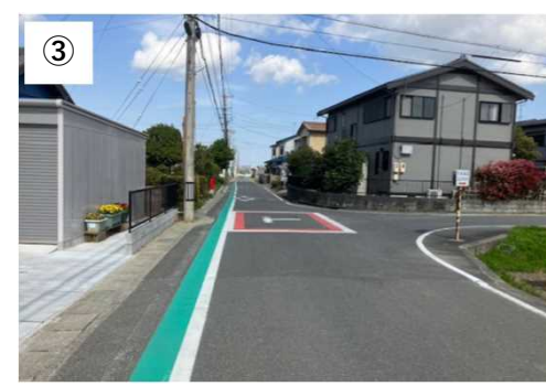
カラー舗装(路肩)
