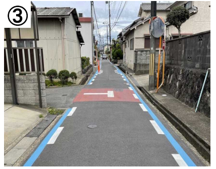
交差点カラー舗装
