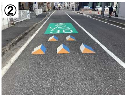
ゾーン30看板・路面表示
