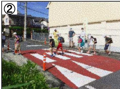
スムーズ横断歩道(予定)※試験施工時
