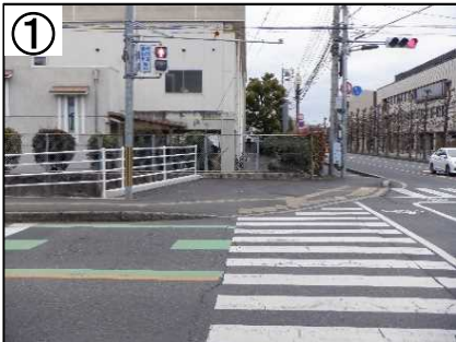
歩道拡幅(滞留空間拡幅)
