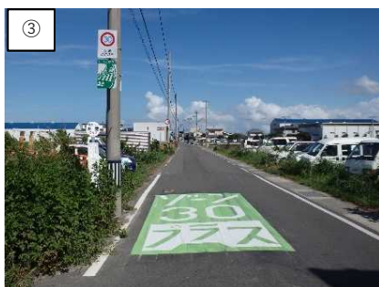
ゾーン30プラス看板・路面表示
