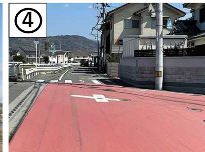
交差点カラー舗装
