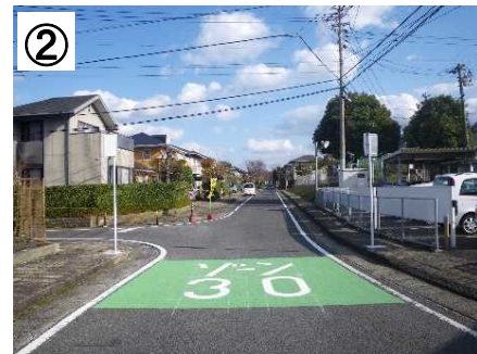
ゾーン30プラス路面表示(プラス表示を予定)
