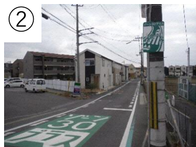
ゾーン30プラス看板・路面表示
