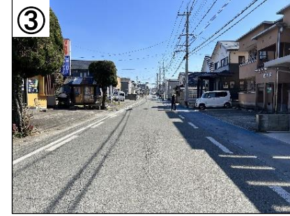
カラー舗装、中央線抹消
