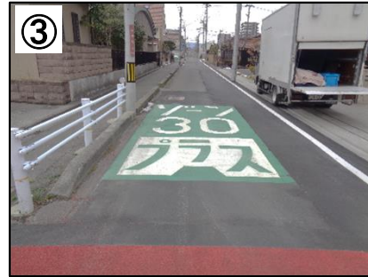
ゾーン30プラス路面表示
