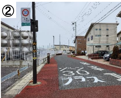
ゾーン30プラス看板・路面表示
