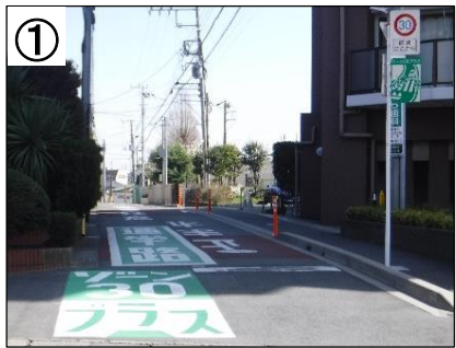
ゾーン30プラス看板・路面表示
