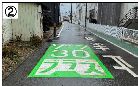
ゾーン30プラス路面表示
