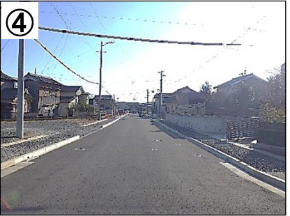
歩道整備(整備中)
