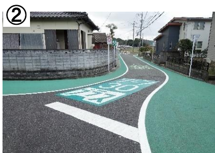
ゾーン30プラス看板・路面表示
