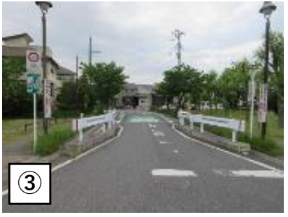
ゾーン30プラス看板・狭さく
