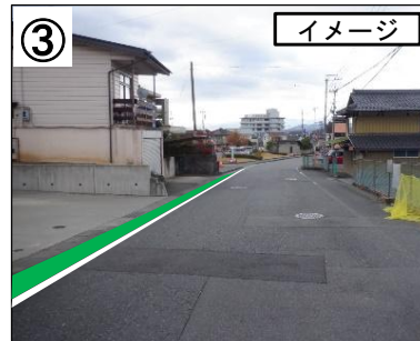
カラー舗装（グリーンベルト）
