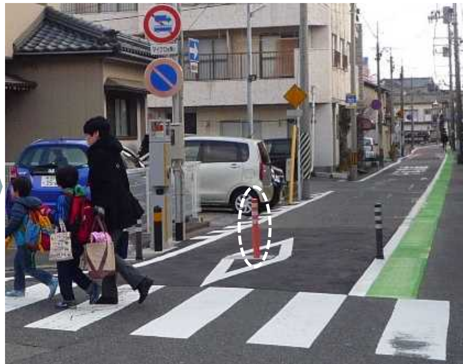
[ボラードが上昇した状態]
