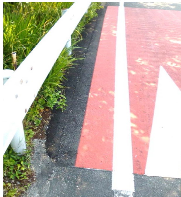
▼アスファルトによる施工状況
