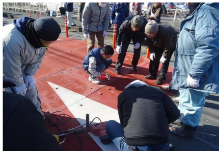
ハンプのゴムキャップ設置
