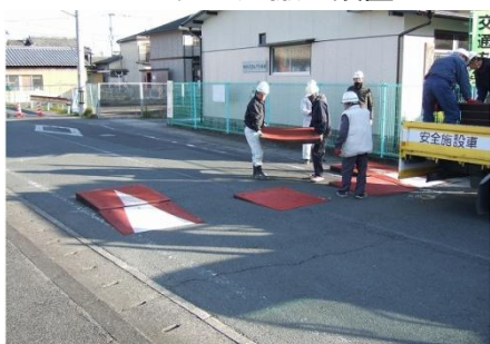
ハンプの運搬・設置
