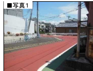
写真1 カーブ区間の状況
