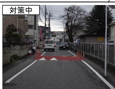
可搬型ハンブ・狭さくを設置(H30.2.23~3.8)、外側線を敷設(H30.2.23~)
