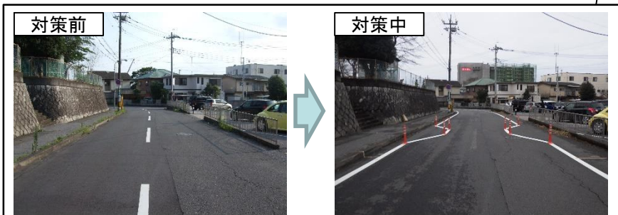
狭さく(3箇所)を設置(H30.2.23~3.8)、外側線を敷設(H30.2.23~)
