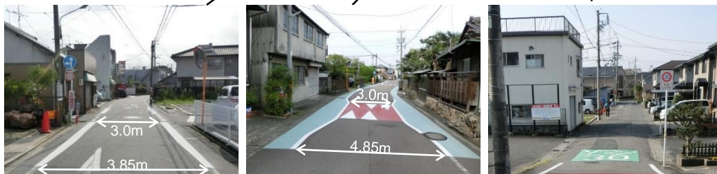
①外側線による狭さく ②狭さく、路肩カラー舗装・イメージハンプ ③ゾーン30明示
