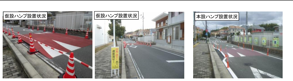
可搬型ハンプを設置 (H30.2:1ヵ月間)
