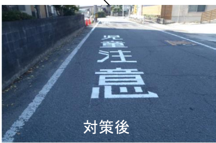
路面標示を実施
