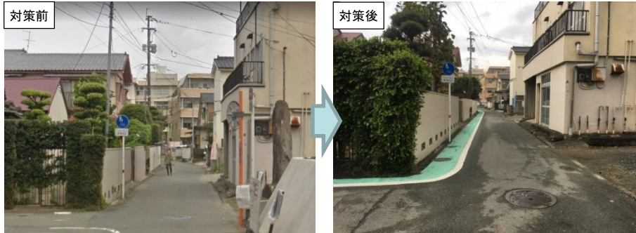
グリーンベルトを設置(H30.3)
