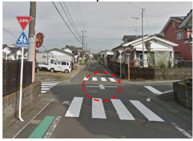
交差点マークを設置
