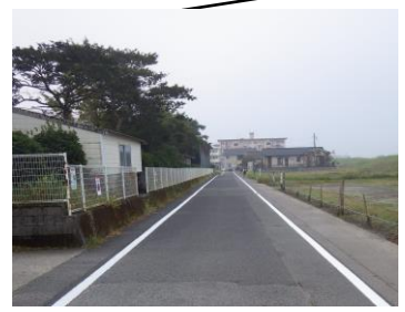
外側線を設置
