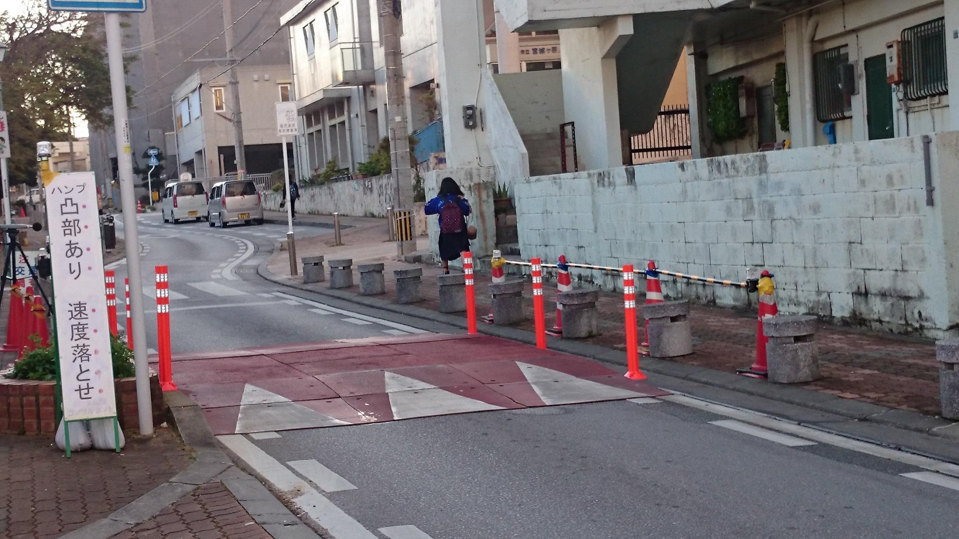
沖縄県浦添市仲西小学校前で実施中のハンプ実験 (長さ6m 平坦部2m) (2015年2月～8月)
