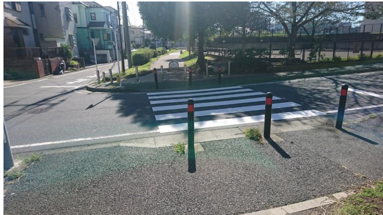
撤去後(通常の横断歩道)
