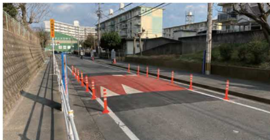
ハンプの試験設置の様子
