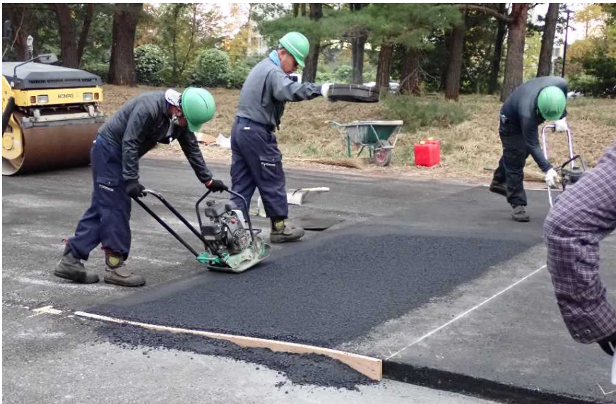
○振動コンパクタやローラで転圧(型枠を目印)
