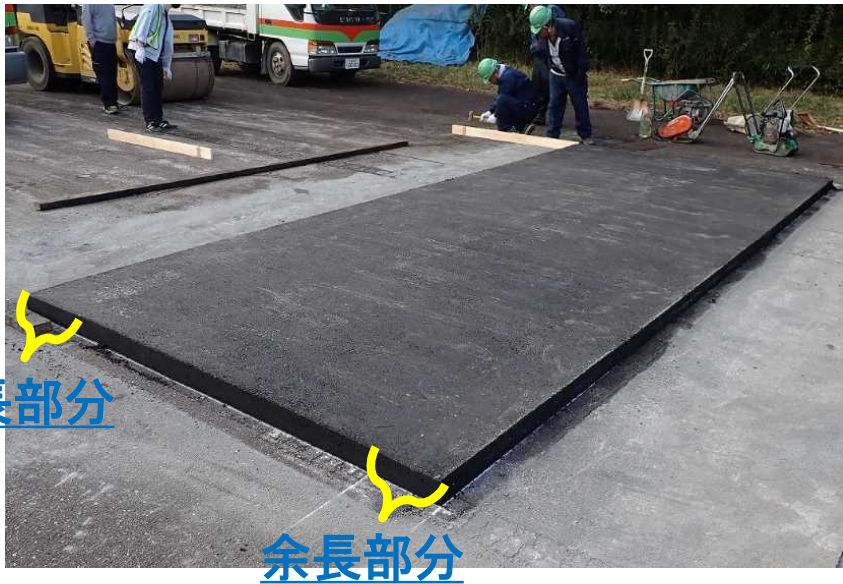
○平坦部の施工
