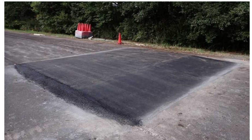
○型枠の撤去・完成
