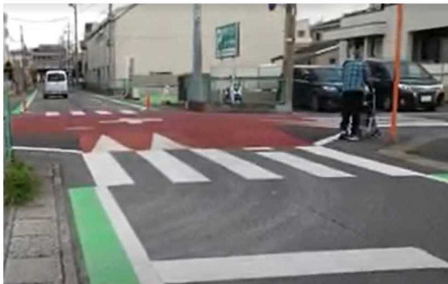
写真 2-1-21 隅切り部に平たんな路面を確保した交差点部ハンプ
