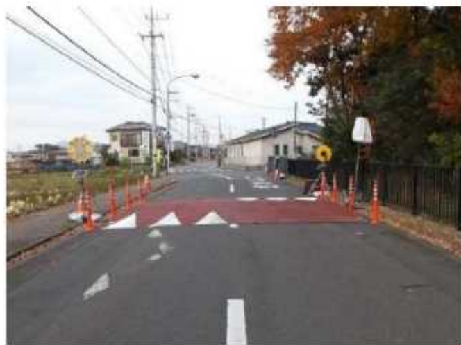
図 3-8. 設置した高さ 10cm の凸部 (つくば市)
