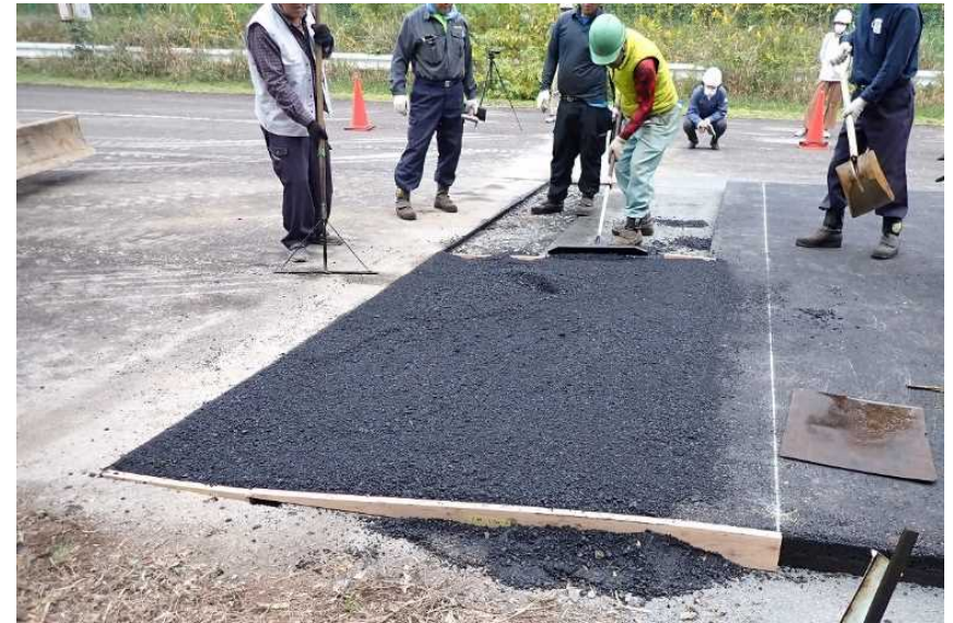
○アスファルト合材敷きならし(型枠を目印)
