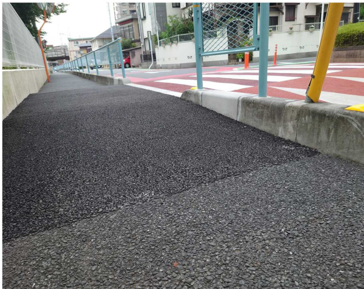
写真 2-1-23 歩道をかさ上げたスムーズ横断歩道 (埼玉県朝霞市)
