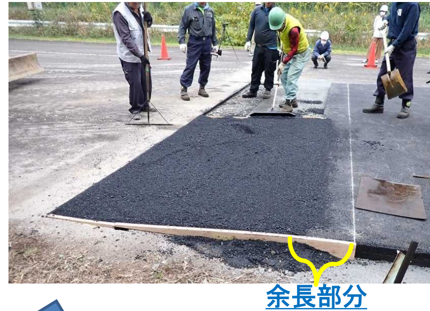
○傾斜部の施工
