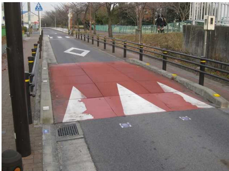
可搬型ゴム製ハンプ(2006年設置)
