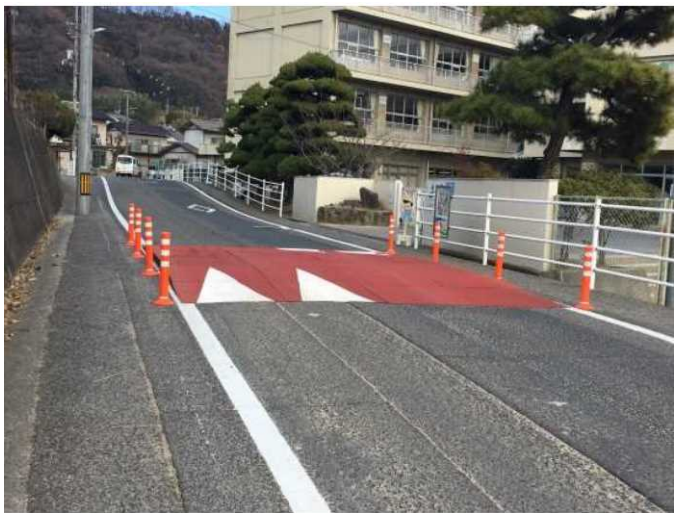
社会実験で設置したハンプ
