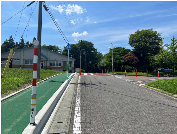
設置された歩道とスノーポール
