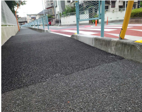
歩道部を嵩上げ
