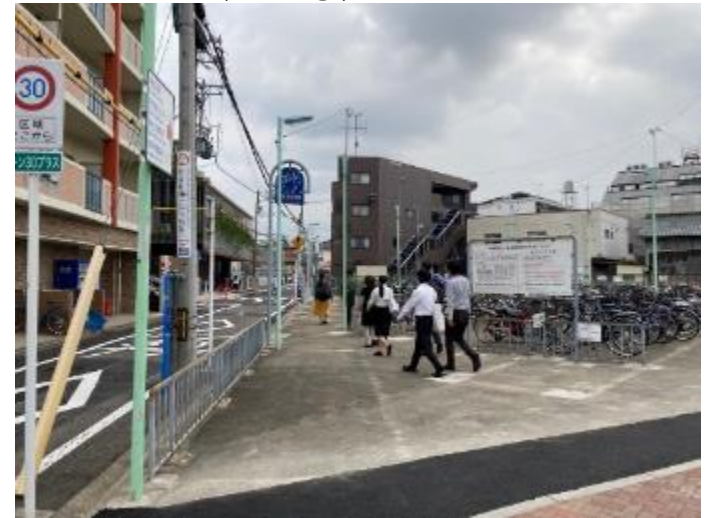
仮設通路（写真②）
