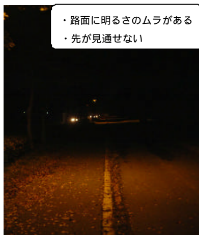
図 均斉度の低い歩道照明
