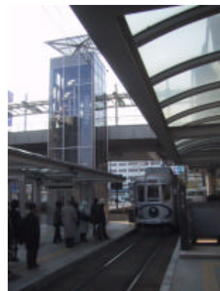
写真 12-2-5 豊橋駅東口駅前広場の路面 公共交通が集中する地上部
