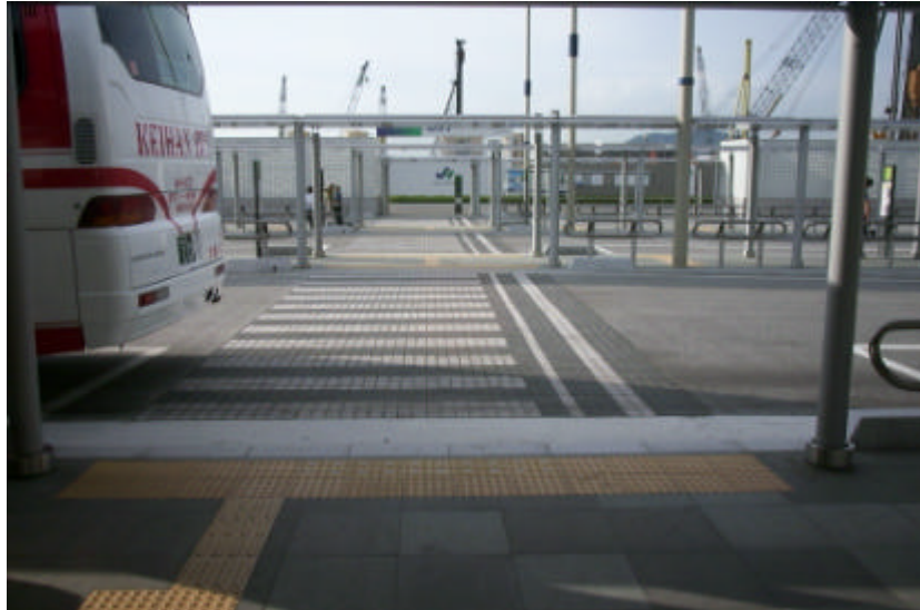
写真 12-2-8 スムーズ横断歩道化された交通島への車道横断部（高松駅前広場・香川県高松市）
