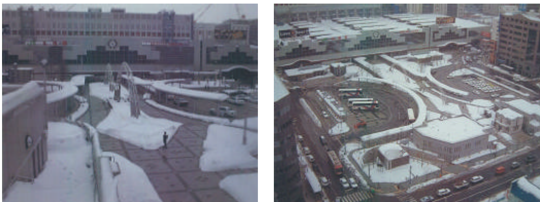
写真 12-2-6 動線上に設置されたロードヒーティング（札幌駅北口広場・北海道札幌市）
