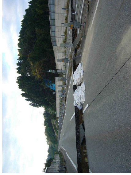
ボックスカルバート取り付け部の盛土の段差 (関越道 小千谷IC～越後川口IC)
