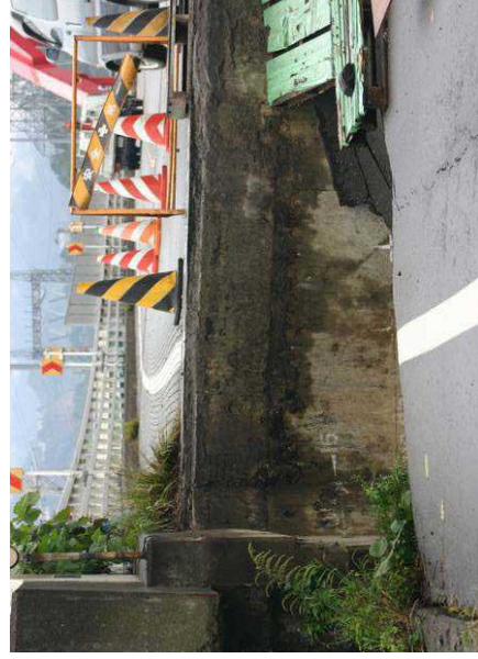
橋梁取り付け部の盛土の崩落 (国道117号 新潟県小千谷市)
