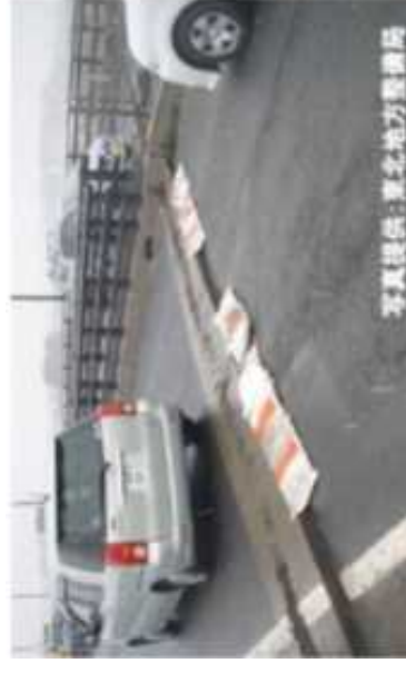
橋梁取り付け部の不等沈下による段差 (国道4号 宮城県大崎市)
