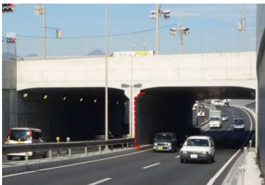
一般国道17号 高松立体(群馬県高崎市)
