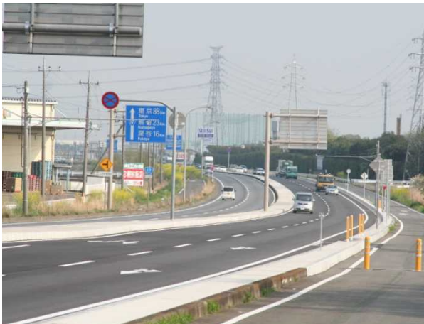
国道17号上武道路(群馬県伊勢崎市)
