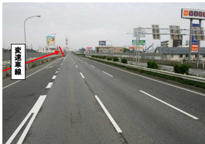
国道8号桜木IC(新潟県新潟市)
