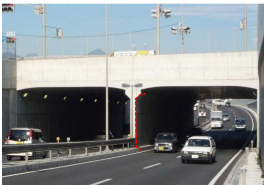
一般国道17号 高松立体(群馬県高崎市)
