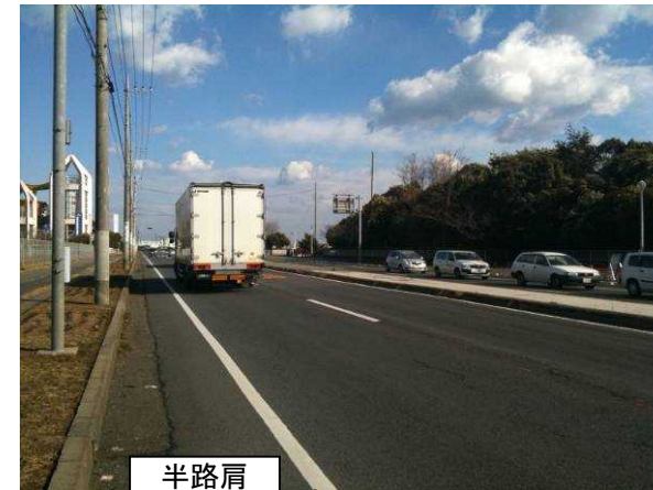
国道245号(茨城県日立市)
