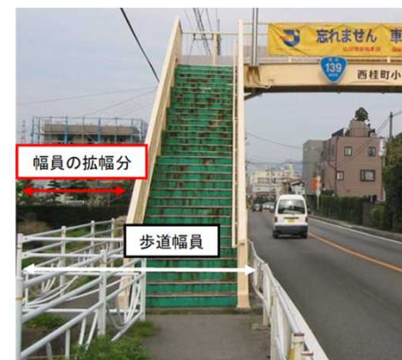
国道139号(山梨県西桂町)
