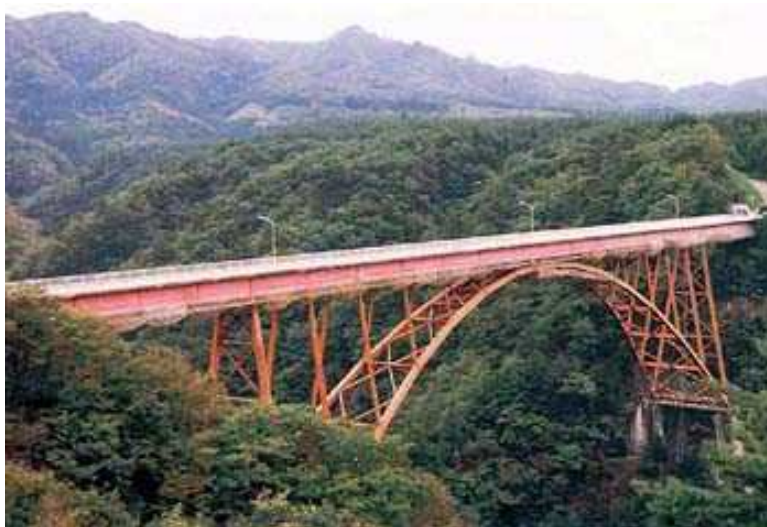
鋼構造（一般国道45号 岩手県下閉伊郡田野畑村）
