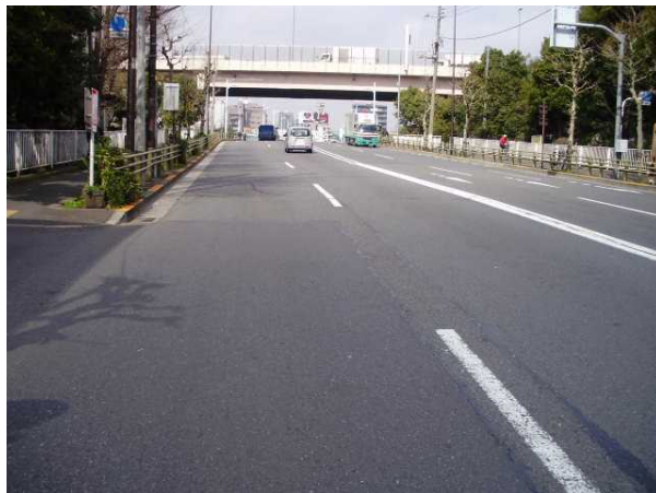
国道6号(東京都墨田区)
