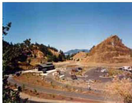
駐車場の整備
