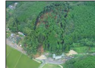
地すべりによる被災(H18台風13号災害)
