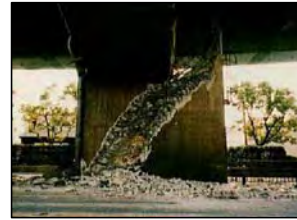
橋梁の被災(兵庫県南部地震)
