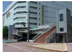
エレベーターの設置された歩道橋
