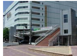
エレベーターの設置された歩道橋
