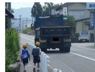
防護柵の設置
